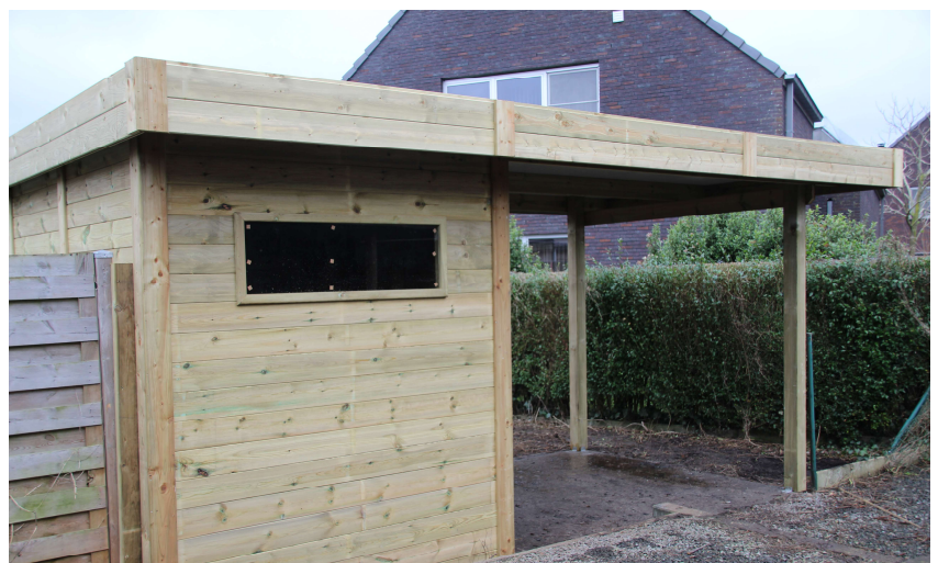
Foto2: plaatsing tuinhuisje met financiële steun van Cera
